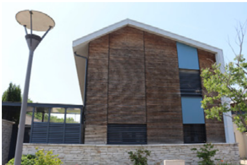
Figura 27. Materiales locales utilizados en la construcción de las viviendas pasivas
