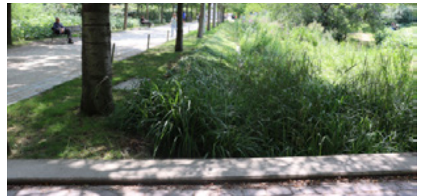
Figura 32. Áreas Canales de infiltración y almacenamiento de agua pluvial que recorren de norte a sur y este a oeste el proyecto
