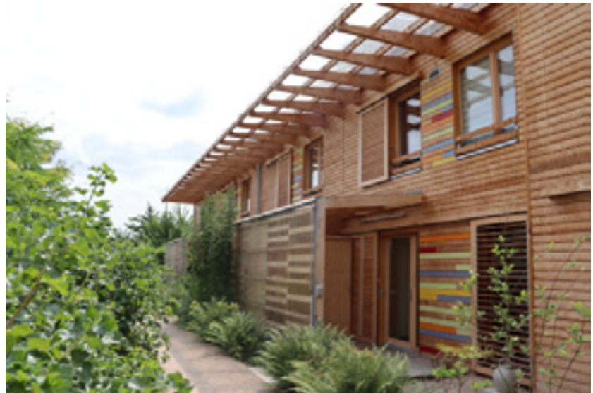
Figura 23. Viviendas de Los Castores diseñadas en madera.
