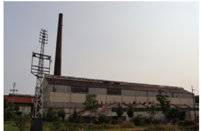
Figura 16. Estructuras industriales recuperadas y reutilizadas.
