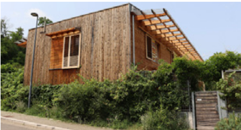
Figura 24. Viviendas de Los Castores utilizan elementos bioclimáticos para aprovechar y difuminar la luz solar.
